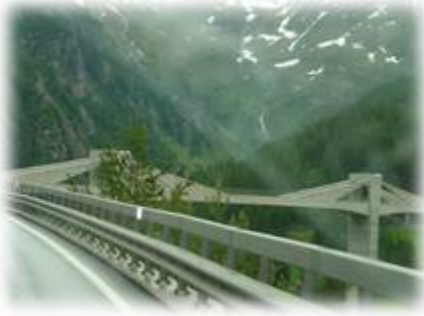
Le pont suspendu sur la route du Simplon
